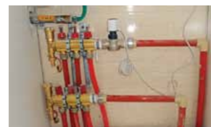
Collecteur Danfoss avec vanne RA-G et actionneur TWA-A. Cette combinaison a été installée dans les petits appartements pour assurer une régulation centrale de la température via un thermostat CWD situé dans la pièce principale. Des régulateurs d'ambiance individuels ont été installés dans les grands appartements.
